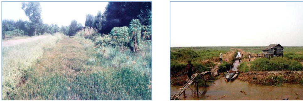
Gambar 4. Saluran drainase yang penuh rumput (kiri) dan prasarana jalan dan jembatan yang minim (kanan)
