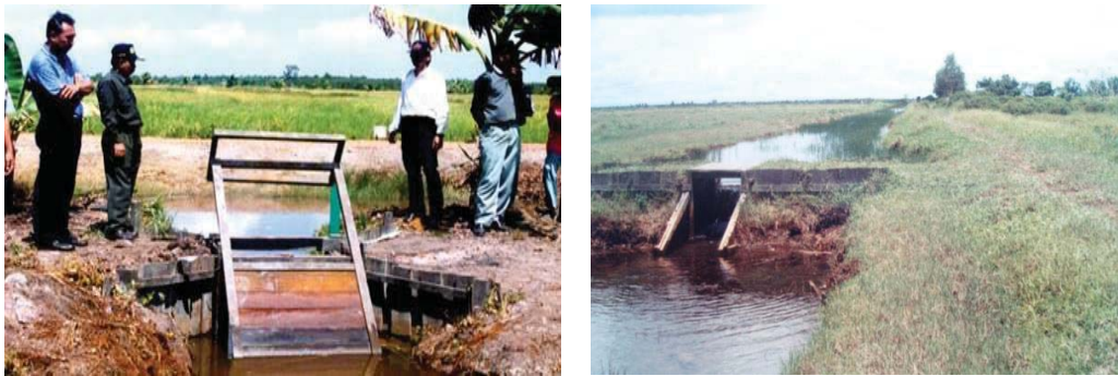
Gambar 6. Jenis pintu air untuk pengelolaan air aliran satu arah berupa flap gate (kiri) dan pengelolaan air dengan sistem tabat overflow (kanan)
